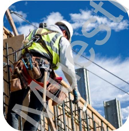
Un trabajador usando equipo de detención de caídas, fíjese en el arnés integral con la cuerda conectada a la espalda
