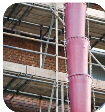
Автономные леса с перилами и настилами. Обратите внимание на желоб для безопасного удаления мусора
