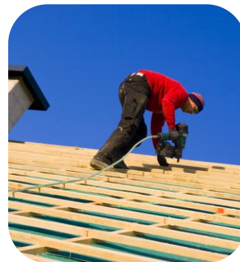
Работа на покатой крыше
